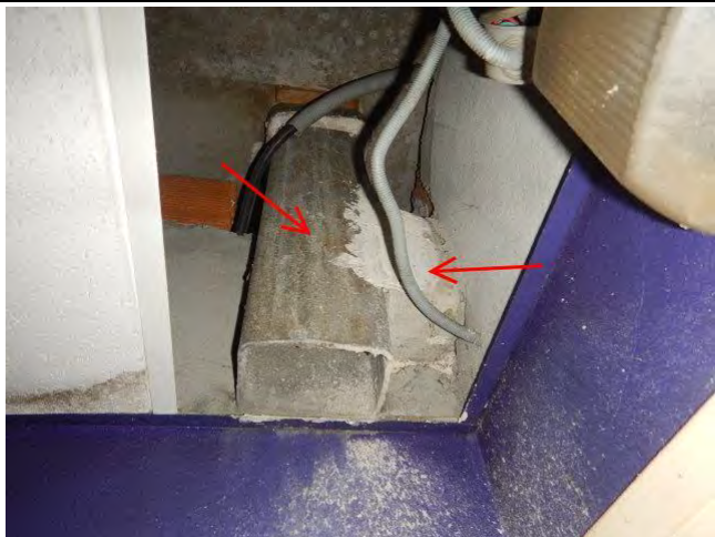
033 : Conduits en fibres-ciment en plénum Sanitaires 6
