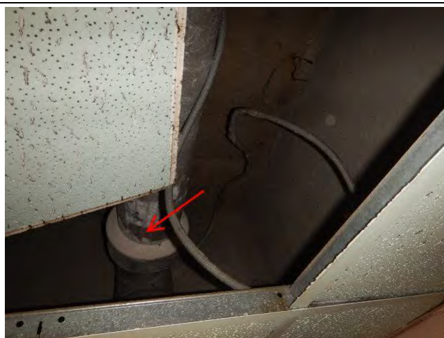
004 : Conduits en fibres-ciment en plénum Sanitaires
