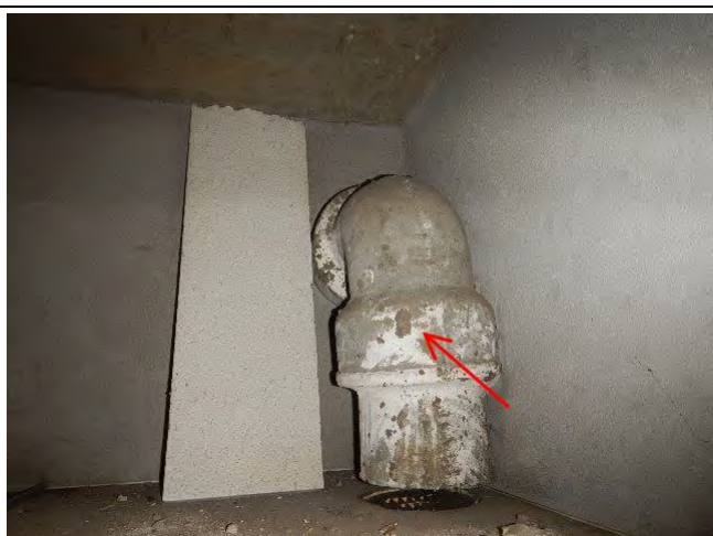
006 : Conduits en fibres-ciment en plénum Sanitaires 2
